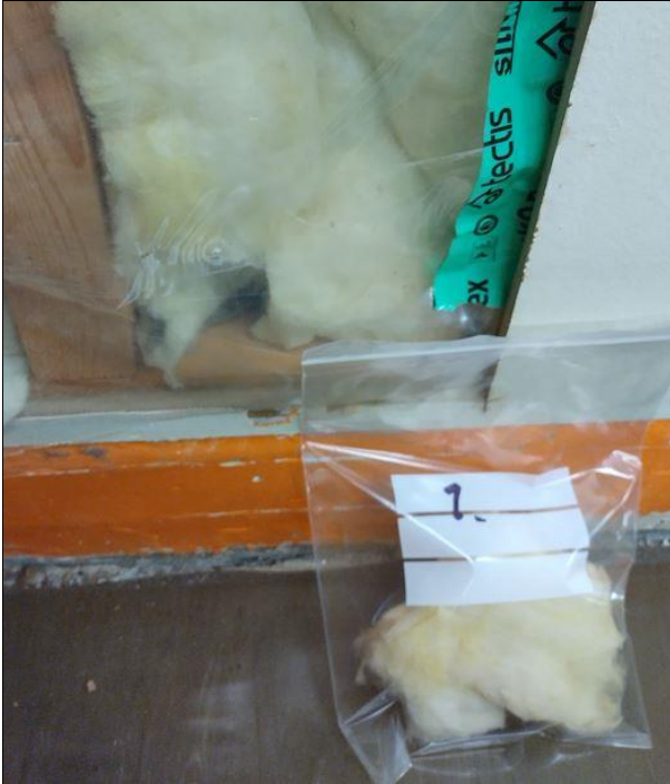
Kuva 7. Lämmöneristenäytteessä ei ollut viitettä mikrobivauriosta.
