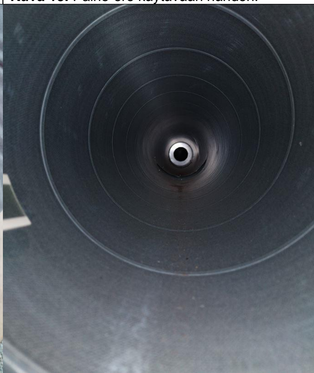
Kuva 15. Tuloilmakanava oli puhdas. Kuvassa geliteippi, jolla otettiin kuitunäyte.
