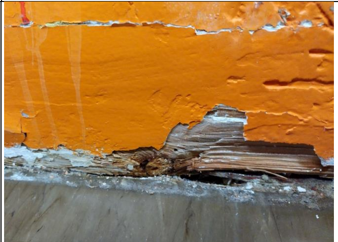
Kuva 8. Alaohjauspuun kosteuspuiteisuus oli 11.4 p-% muutaman sentin syvyydellä. Arvo on normaali.
