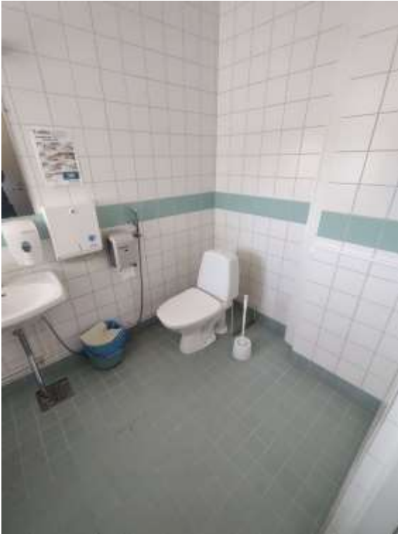
Kuva 8 Toisen kerroksen esteetön wc
