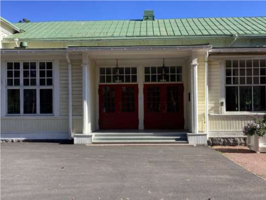
Kuva 1 Hangon Casinon sisäänkäynnin edusta
