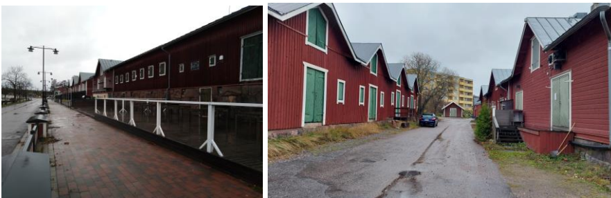
Kuva 25 Makasiinikortteleissa on saman aikakauden rakennuksia kahdessa rivissä.
