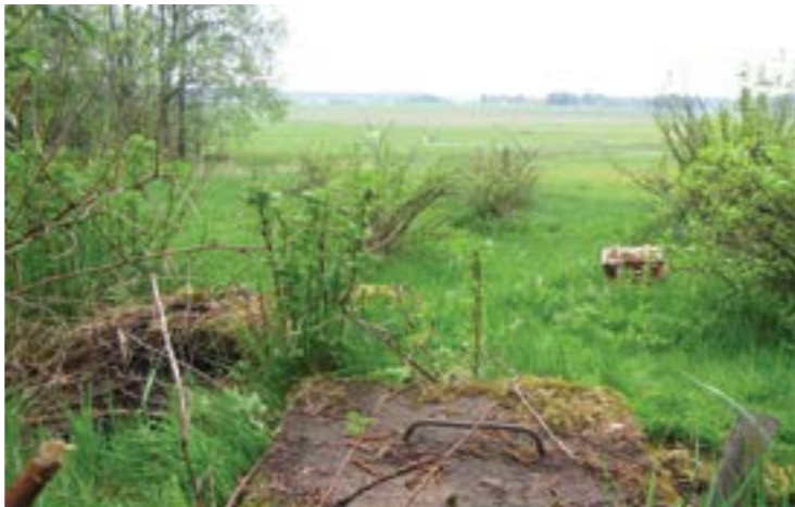
Avloppssystemen syns vanligtvis endast som ovanjordiska rör och brunnslöck. Under marken döljer sig slamavskiljare eller -brunnar, slutna tankar och reningsverk som behöver tömmas med jämna mellanrum. (Bilder: Länsi-Uudenmaan vesi ja ympäristö, LUVY)
