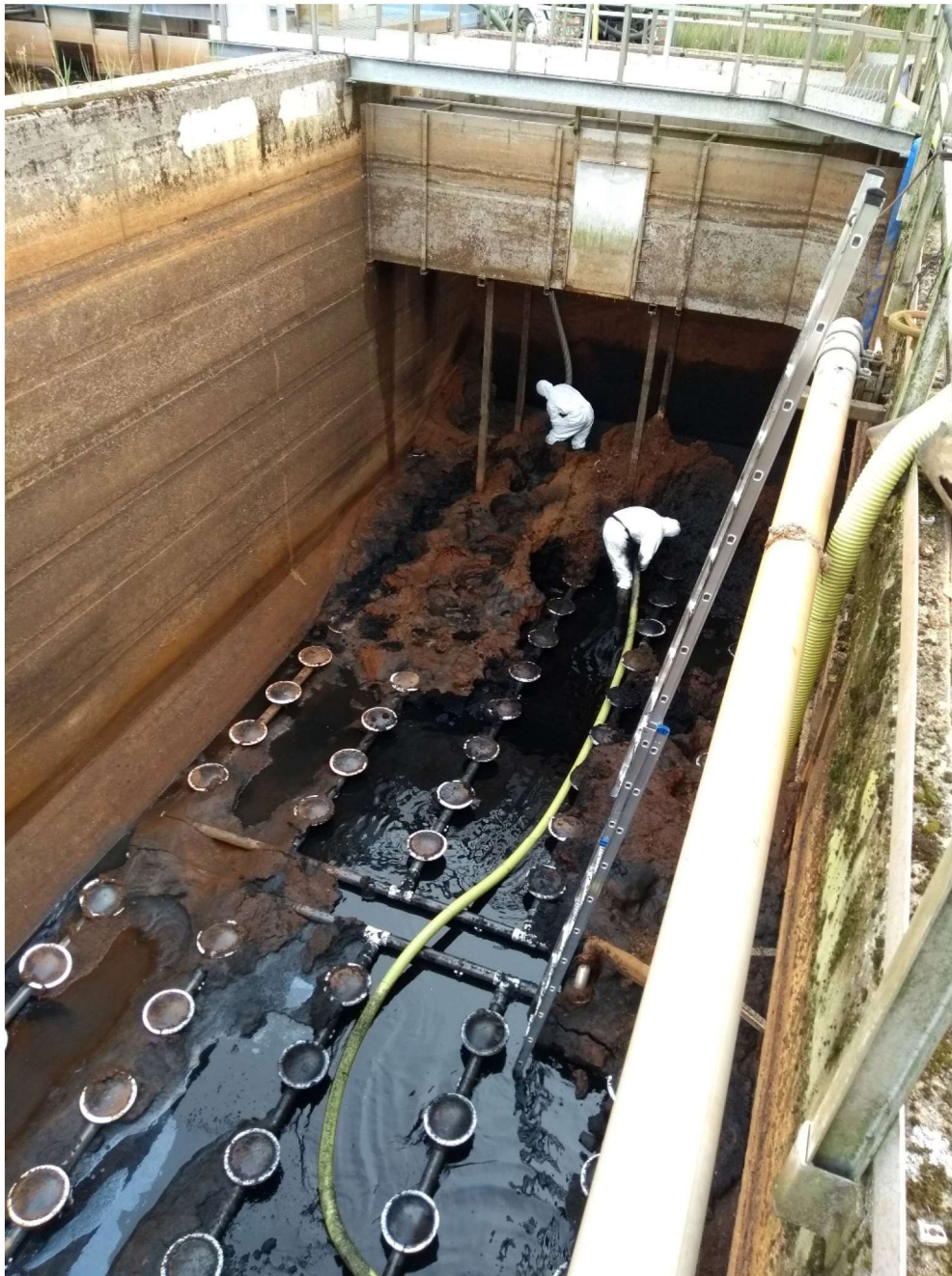
Kuva 5. Ilmastusaltan tyhjennys Bild 5. Tömning av luftningsbassäng
