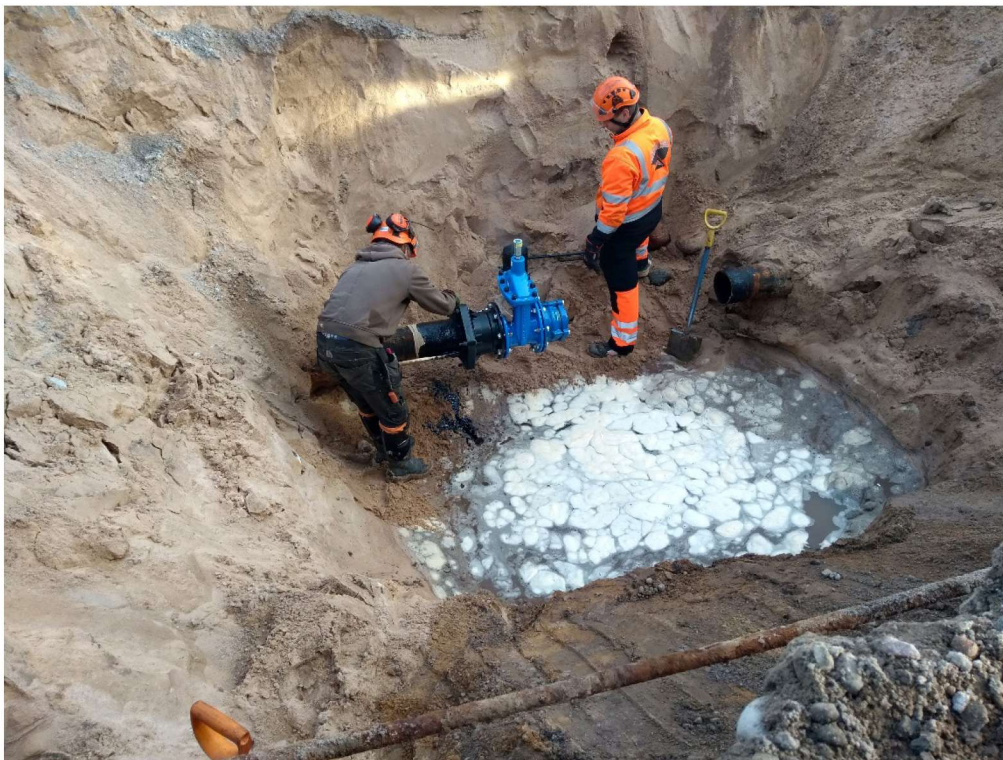
Kuva 2. Liitostyö Lähteentiellä Bild 2. Kopplingsarbete på Källvägen
