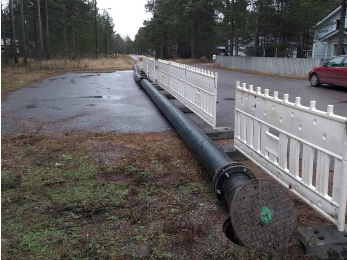
Kuva 1. Purkuputken saneeraus sukkasujutuksella edellytti putken ohituspumppausjärjestelyitä.
