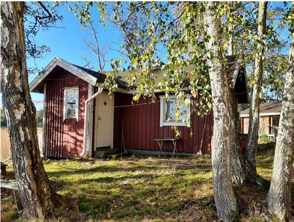
Kuva 3. Alueella oleva asuinrakennus. Rakennuksen rakennusvuodesta ei ole tarkkaa tietoa, mutta se on joka tapauksessa rakennettu ennen kuin rakennuslupakäytäntö ryhdyttiin soveltamaan 1950-luvulla. Alla olevasta peruskarttaotteesta vuodelta 1953 näkyy alueella silloin toiminnassa olleen asutustilan rakennuskanta. Asuinrakennus on siinä vaiheessa rakennettuna. Peruskarttaotteesta vuodelta 1966 asuinrakennus on karttamerkitty asuinrakennukseksi. Siinä vaiheessa pari talousrakennusta on jo purettu.
