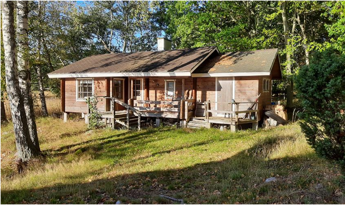
Kuva 2. Alueella oleva saunarakennus. Rakennuslupa on myönnetty v. 1991.
