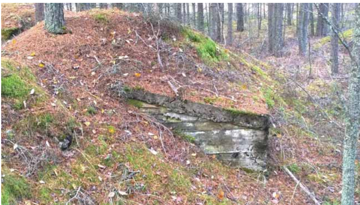
AKDG 3927:7. Betonirakenne keskimmäisen ratapenkan länsipäässä, kaakosta. Kuvaaja: Petro Pesonen.
