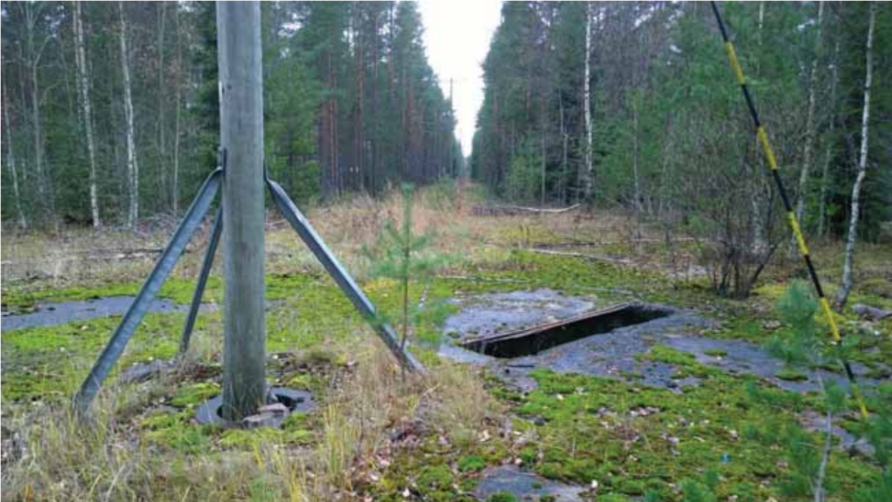
AKDG 3927:2. Betonilavetti ja eteläisintä ratapenkkää länteen päin, idästä. Kuvaaja: Petro Pesonen.
