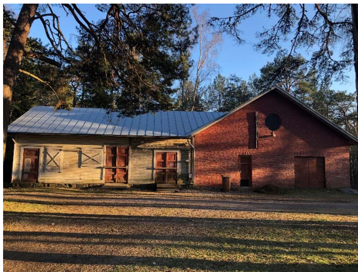
Iskällarens byggnad på planområdet.
