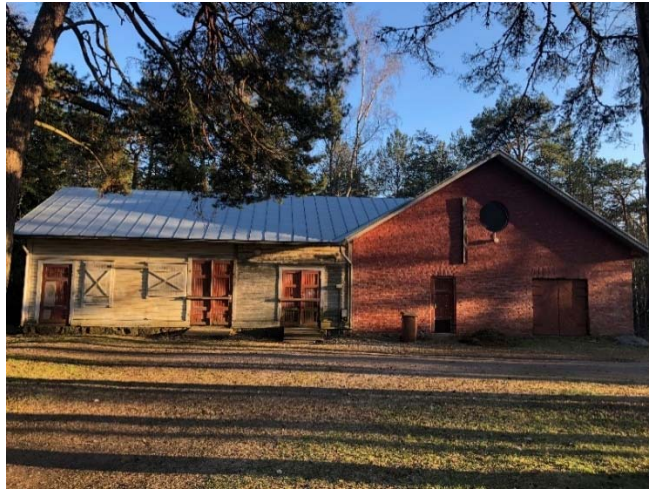
Jääkellarin rakennus suunnittelualueella.
