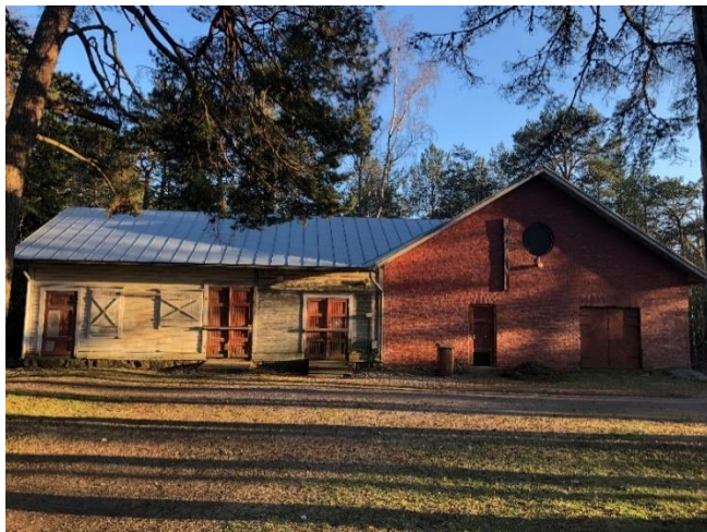
Jääkellarin rakennus suunnittelualueella.
