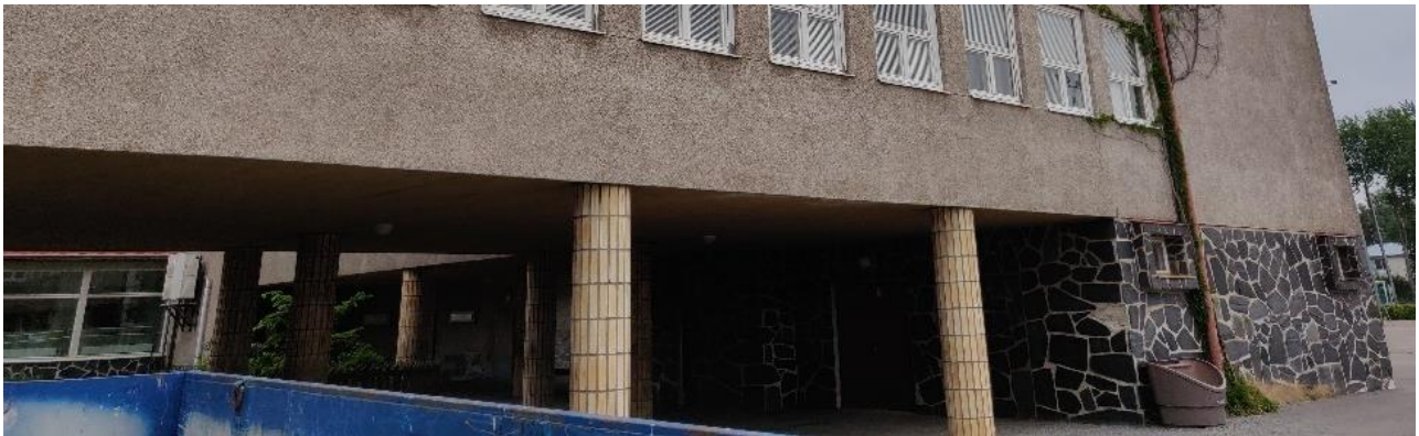
Kuva 5. Alapohjarakenne rajautuu ulkoilmaan alapuolelta.
