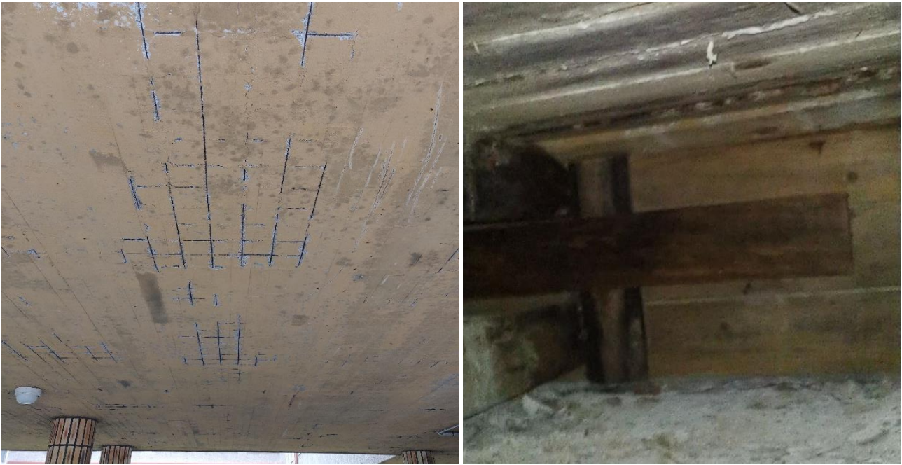
Kuva 6. Alapohjarakenteen alapinnassa on raudoitusverkko näkyvässä. Alapohjarakenteen kotoissa on muottilaudo.
