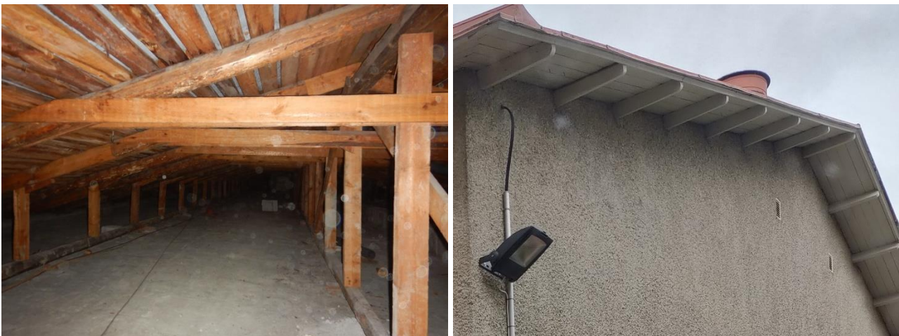
Kuva 12. Yleiskuvat yläpohjan tuuletustilasta sekä eteläseinässä olevista tuuletusaukoista.
