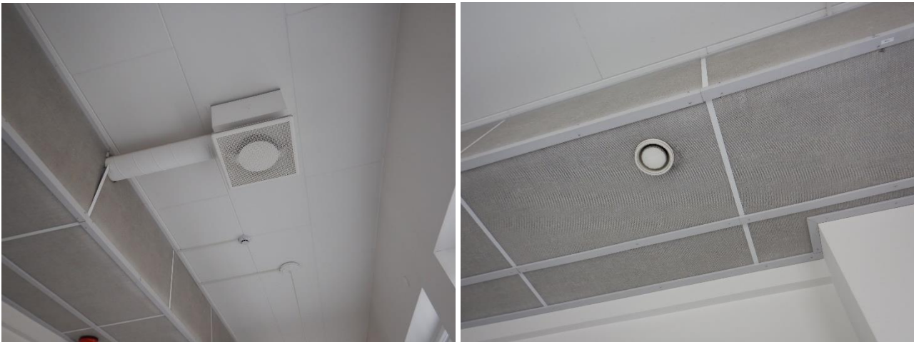
Kuva 15. Käytävän katto ja kotelon villalevyt.
