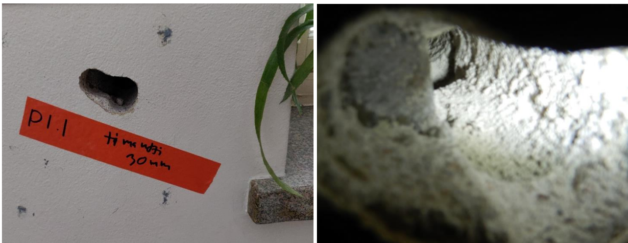
Kuva 2. Pilarin sisäpuolelle tehty rakenneavaus.
