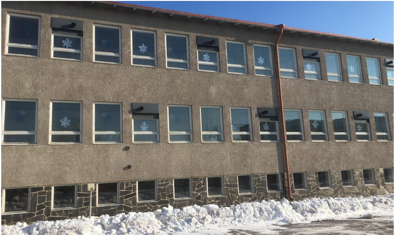
Kuva 9. Rakennuksen eteläsiiven julkisivu on rapattu ensimmäisen ja toisen kerroksen osalta.
