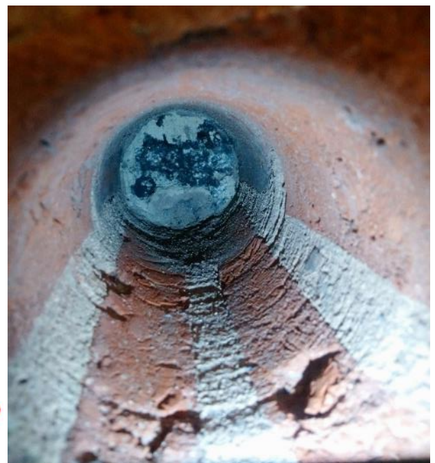
Esimerkkikuva. PAH-yhdisteitä sisältävän pikisivelyn sijainti vanhassa rakennuksessa (Rakennustieto, kerrostalot 1880-2000).
