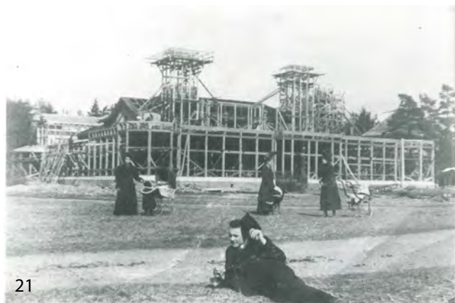
Ravintolarakennusta laajennetaan ja meren puolelle rakennetaan uusi julkisivu. Kuva on otettu 4.4.1910.
