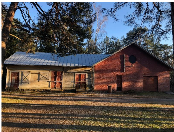
Iskällarens byggnad på planområdet.
