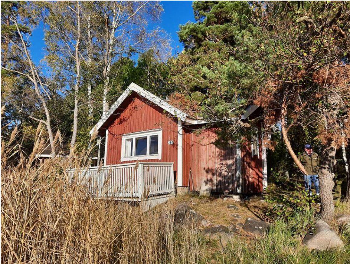
Kuva 6. Asuinrakennus nykytilassa rannasta kuvattuna.
