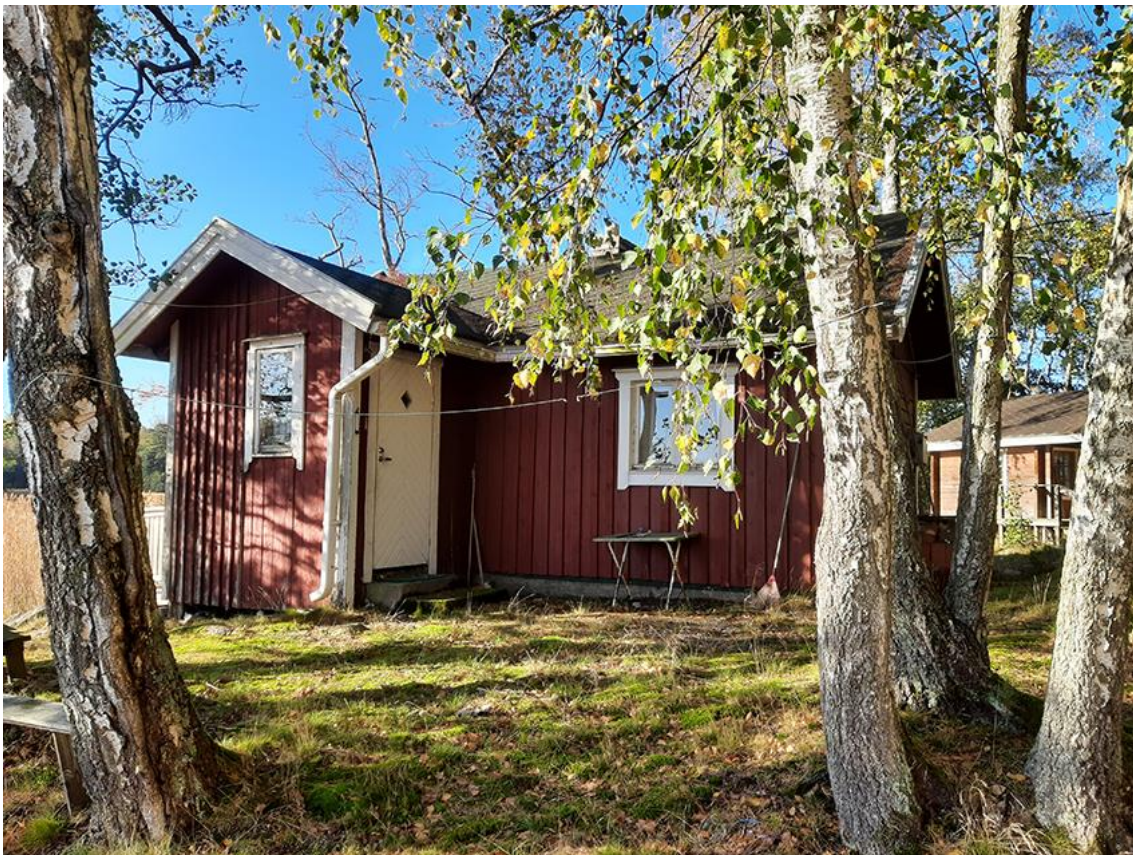
Kuva 7. Asuinrakennus idästä päin kuvattuna, taustalla saunarakennus.
