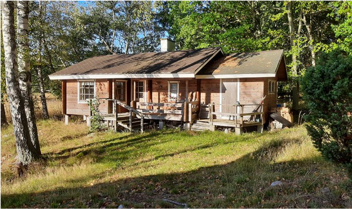
Bild 2. Bastun på området. Bygglovets är beviljat 1991.
