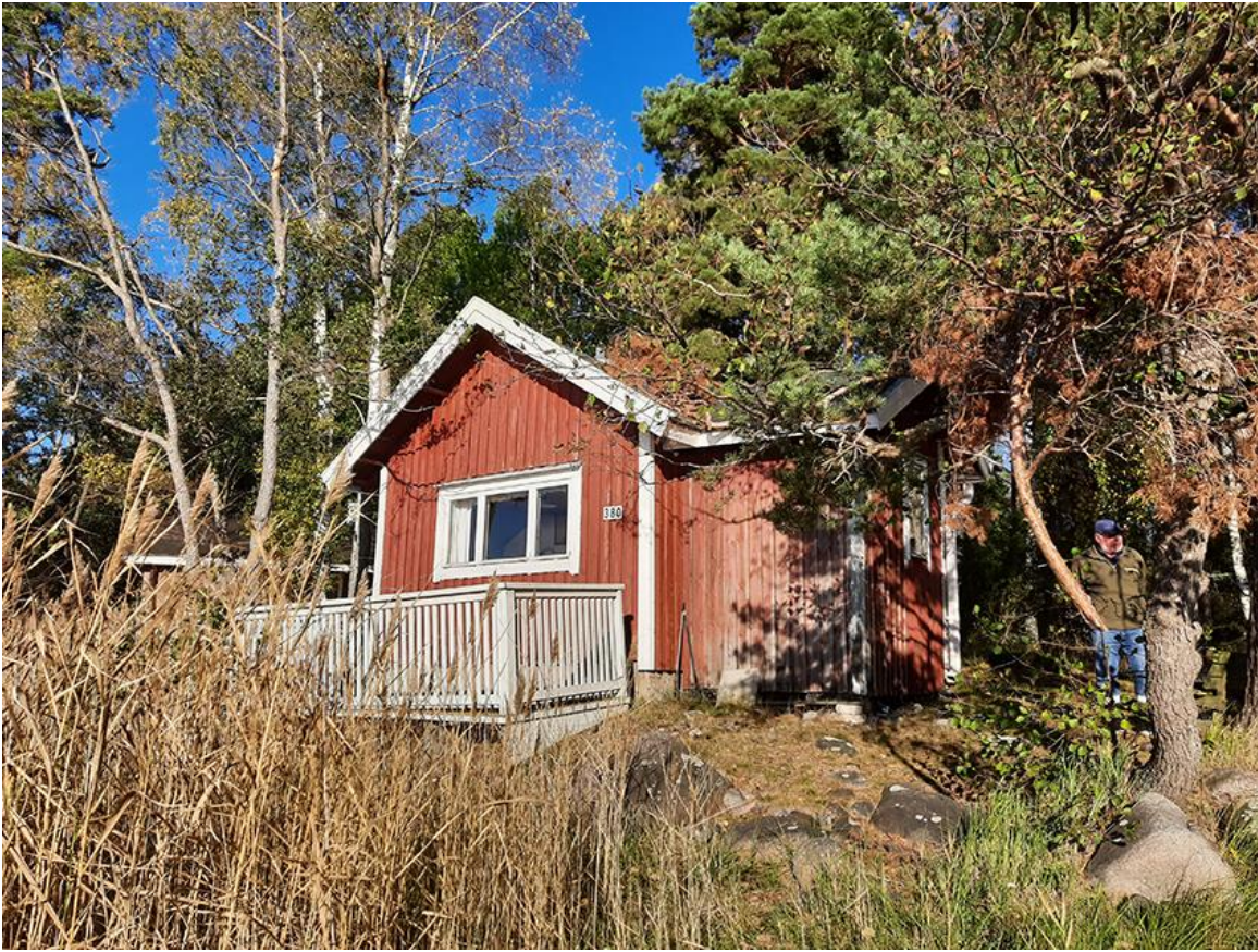
Bild 6. Bostadsbyggnaden i nuvarande skepnad fotograferad från stranden.
