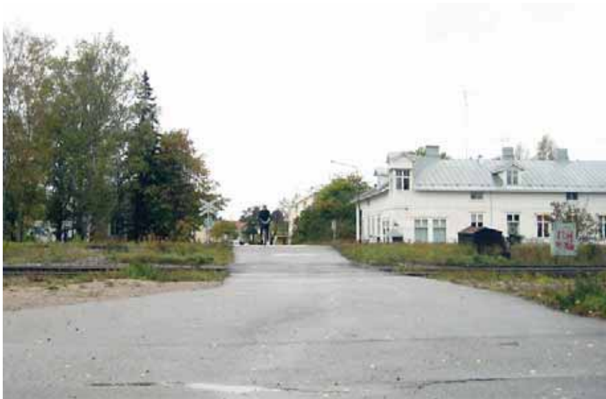
Kuva 6.5 Kadermonkadun kohdan rautatien alikulun rakentaminen
