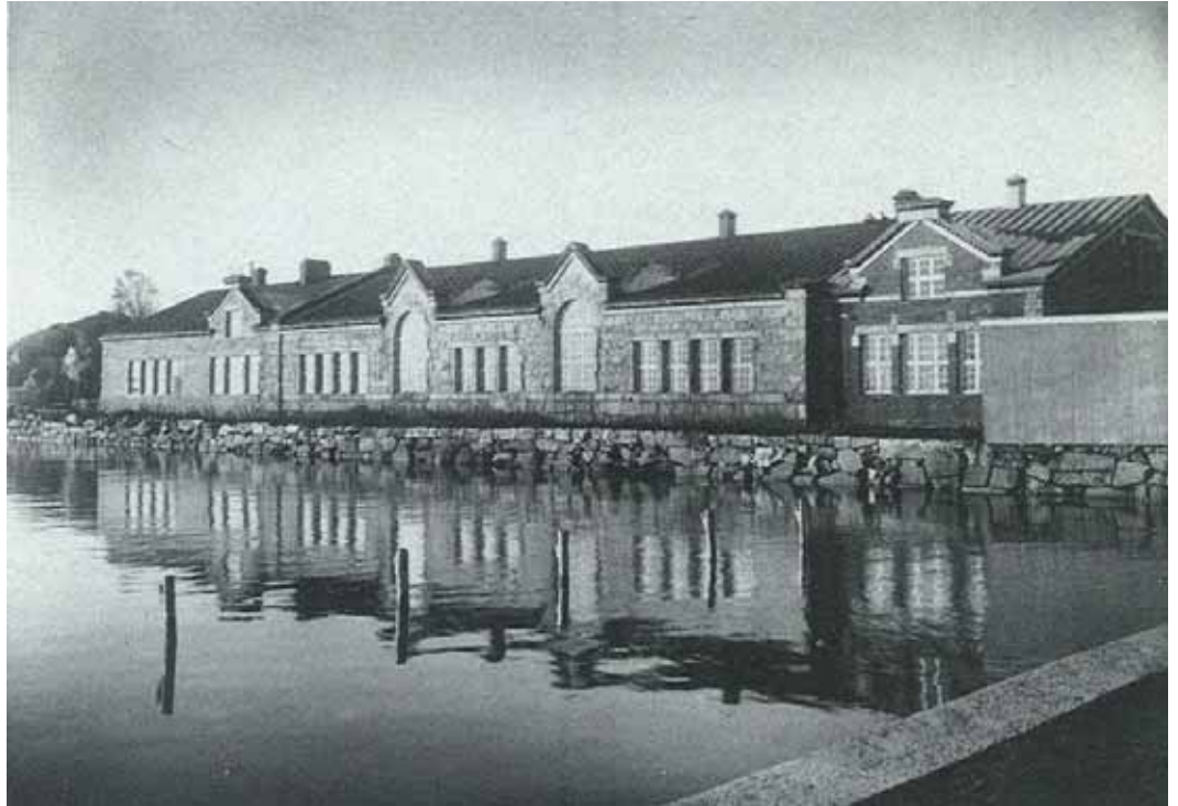
Ab Granits sliperibygnad vid Östra hamnens väststrand efter utvidgningen år 1928.
