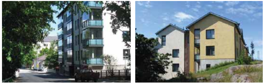
Kompletteringsbyggande i centrum vid Nycandergatan och Gengatan
