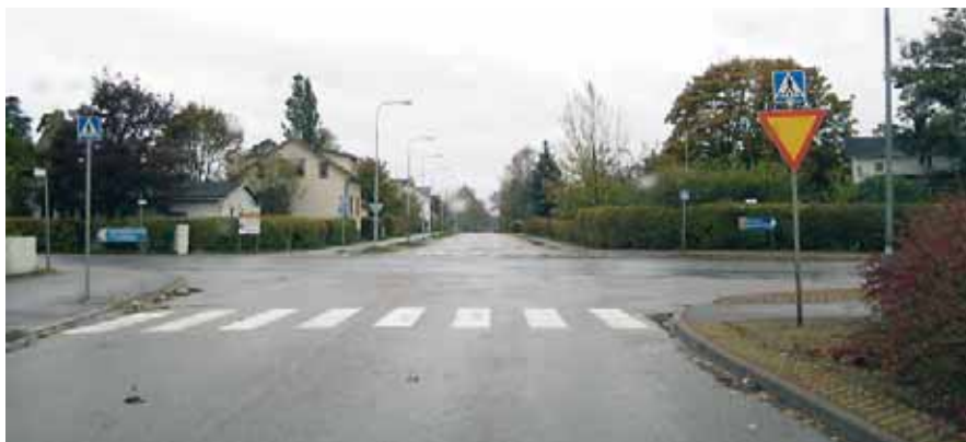
Kuva 6.9 Liittymäalueen kaventaminen Esplanaadin ja Hangonkyläntien liittymässä.
