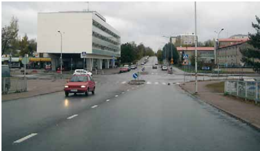
Kuva 6.7 Kiertoliittymän rakentamista esitetään Esplanaadin ja Halmstadinkadun liittymään.
