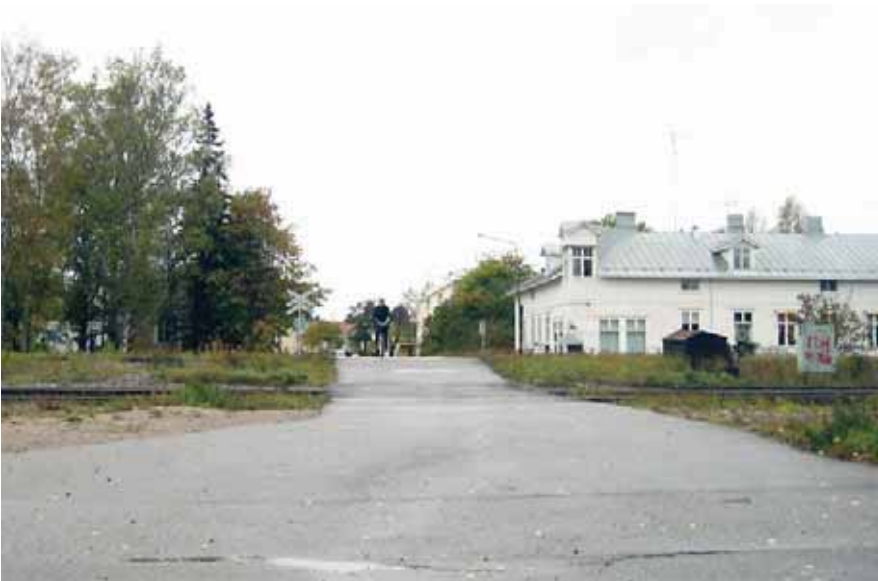
Kuva 6.5 Kadermonkadun kohdan rautatien alikulun rakentaminen
