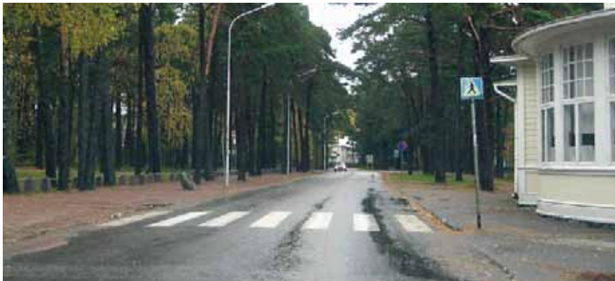
Kuva 6.3 Casinon kohdan suojatien korottaminen.
