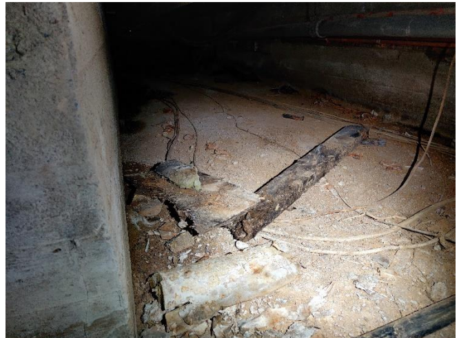
Kuva 20. Rakennusjätettä putkikanaalissa.
