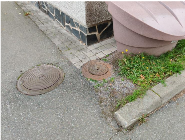
Kuva 8. Salaojien tarkastuskaivo.
