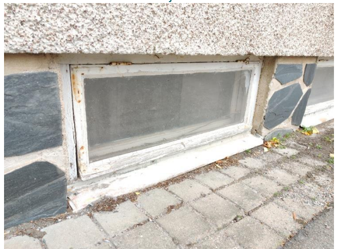
Kuva 33. Länsisiiven länsiseinustan kellarin ikkuna.
