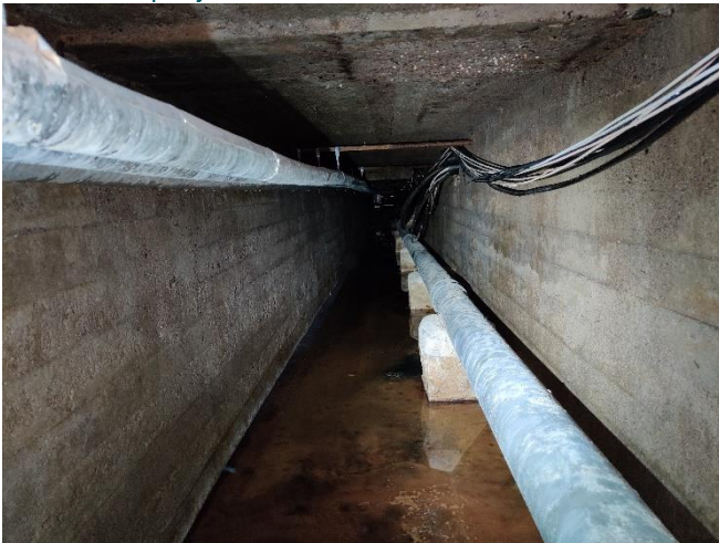
Kuva 19. Putkikanaalissa vettä.
