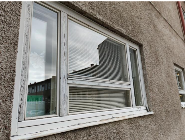
Kuva 30. Länsisiiven eteläseinustan ikkuna.
