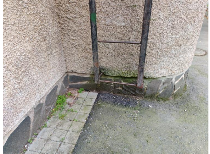
Kuva 15. Länsisiiven pohjoisseinän sokkeli.
