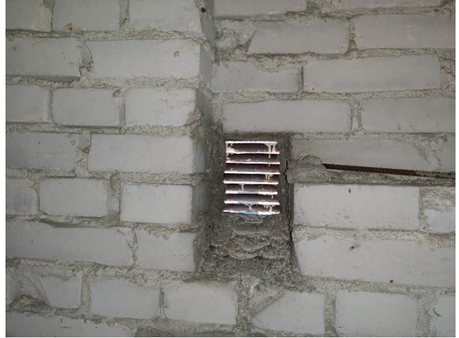
Kuva 39. Yläpohjan tuuletusaukko.
