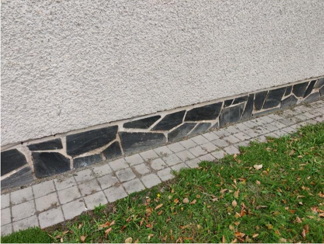
Kuva 14. Länsisiiven eteläseinän sokkeli.
