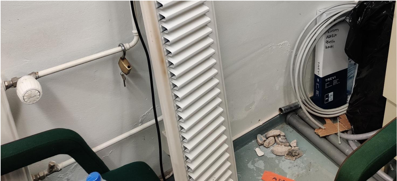
Kuva 13. Länsisiiven kellarin seinä.
