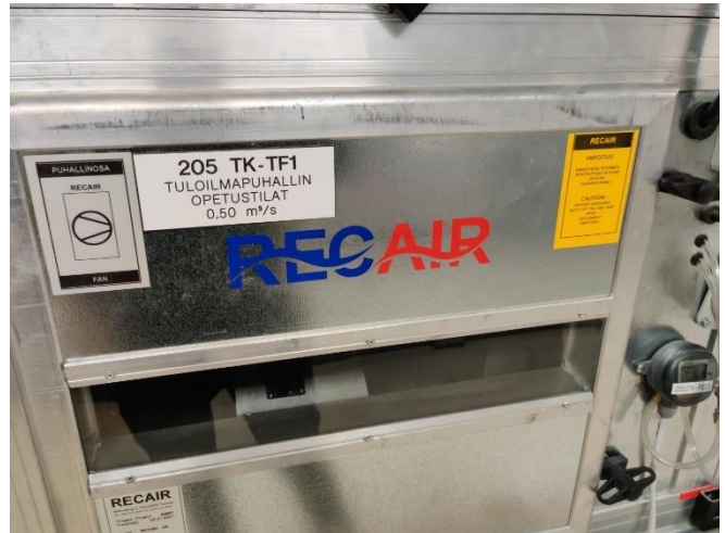
Kuva 48. Tuloilmapuhallin.
