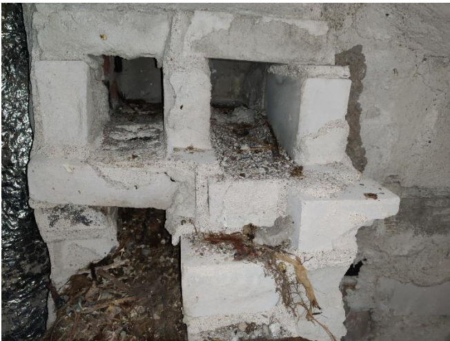
Kuva 40. Yläpohjan tuuletushormit.
