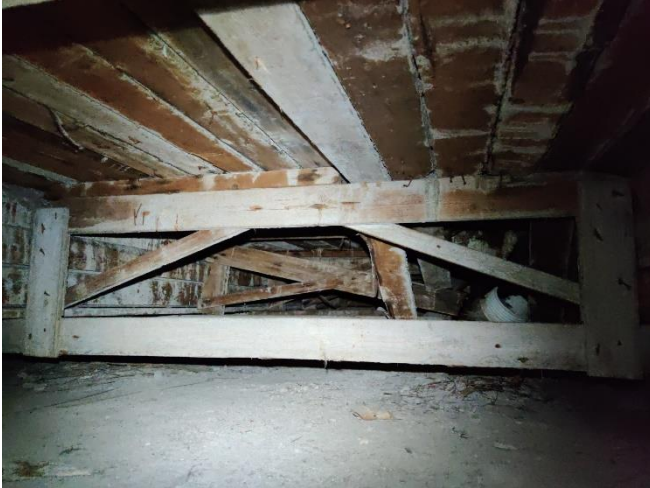
Kuva 17. Alapohjarakenteen AP5 alla olevat muottilaudat.
