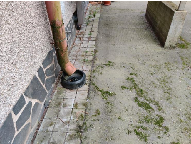
Kuva 10. Länsisiiven sadevesien ohjaus.
