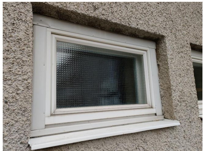
Kuva 31. Länsisiiven märkätilojen ikkuna.
