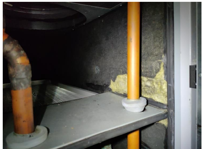
Kuva 50. Koneen sisäosassa villapintoja näkyvissä.
