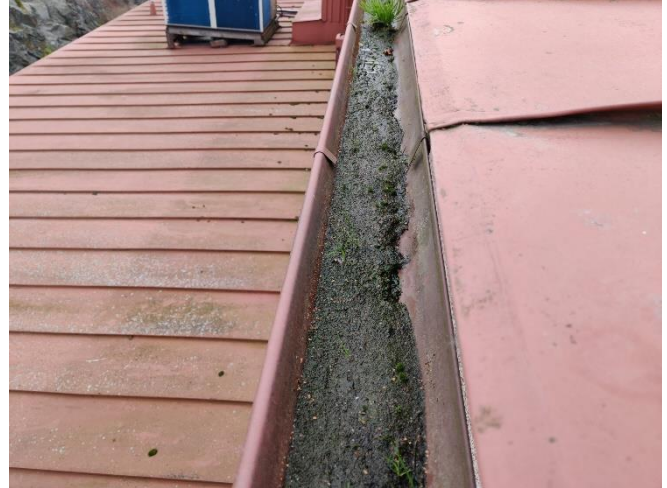
Kuva 46. Keittiön yläpuolisten tilojen rännikouru.
