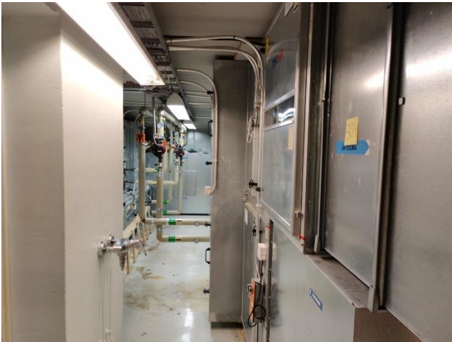
Kuva 47. Länsisiiven IV-koneet.
