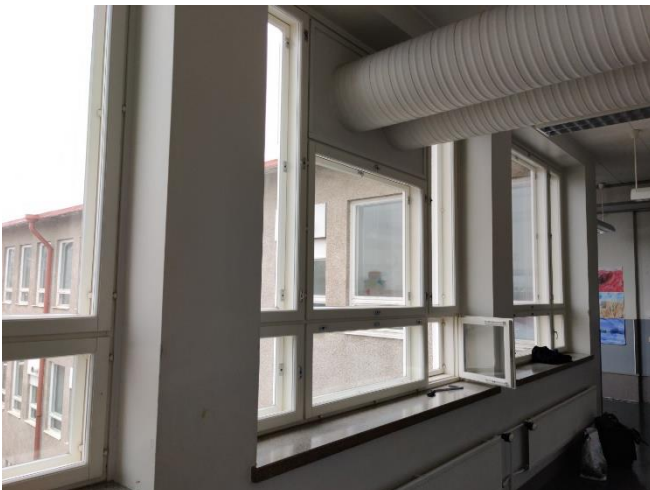
Kuva 48. Käytävän 1990-luvulla uusittu ikkuna.
