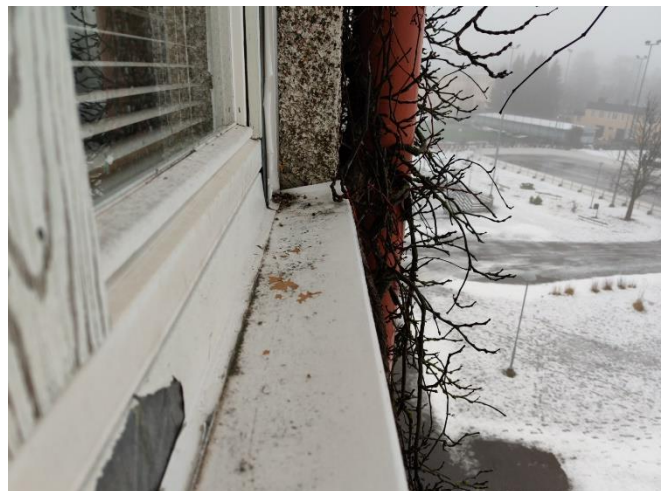
Kuva 47. Luokkien 1980-luvulla uusittu ikkuna.
