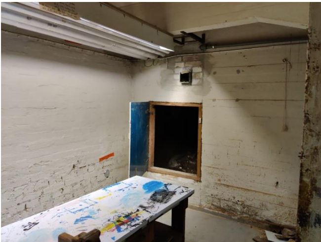
Kuva 19. Luokku itäsiiven itäpäädyn käytävän alla olevaan putkikanaaliin/ryömintätilaan.
