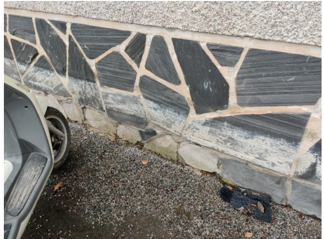
Kuva 16. Itäsiiven pohjoisseinän sokkeli.
