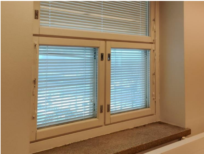
Kuva 44. Luokkien 1980-luvulla uusittu ikkuna.
