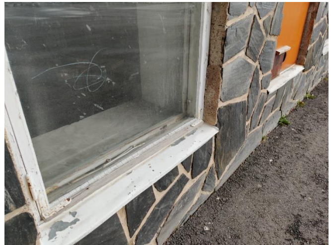
Kuva 41. Itäsiiven kellarin alkuperäinen ikkuna.
