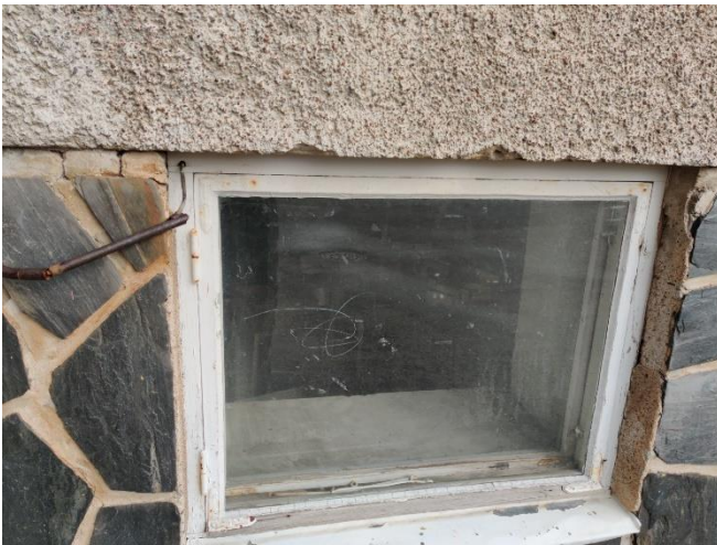
Kuva 40. Itäsiiven kellarin alkuperäinen ikkuna.
