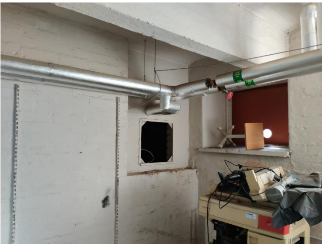
Kuva 25. Luokku itäsiiven itäpäädyn luokkien alla olevaan ryömintätilaan.
