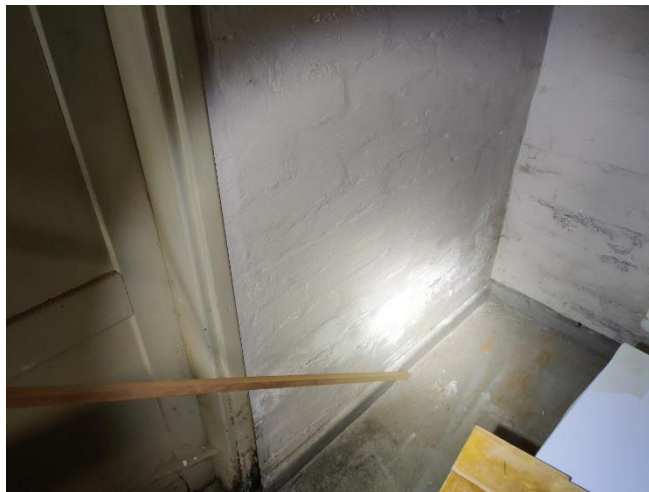
Kuva 14. Itäsiiven kellarin seinä.
