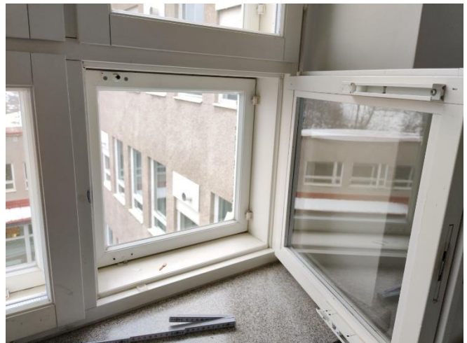
Kuva 49. Käytävän 1990-luvulla uusittu ikkuna.
