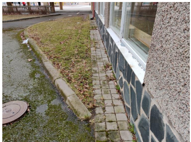
Kuva 8. Sisäpihalla sokkelin vieressä on pihakivetyt.
