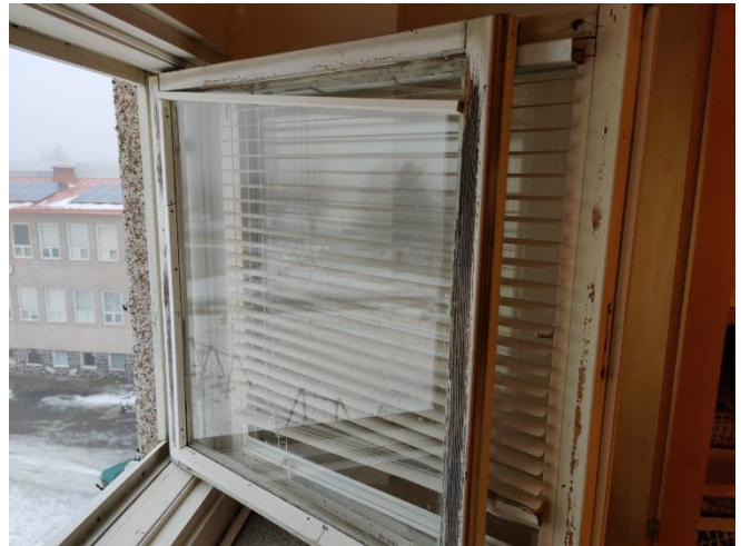
Kuva 45. Luokkien 1980-luvulla uusittu ikkuna.
