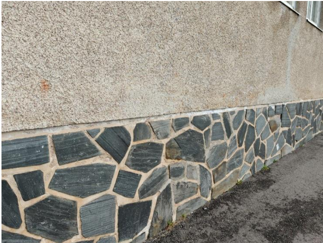
Kuva 15. Itäsiiven eteläseinän sokkeli.
