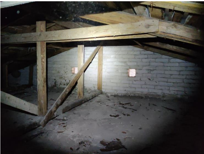
Kuva 54. Päätökolmiossa olevat tuuletusaukot.
