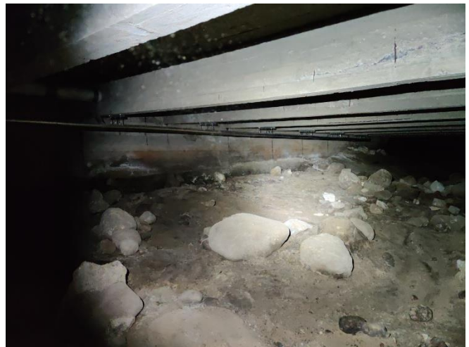
Kuva 26. Luokkien alla oleva ryömintätila.
