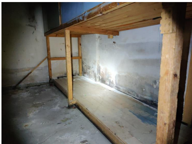
Kuva 13. Itäsiiven kellarin seinä.
