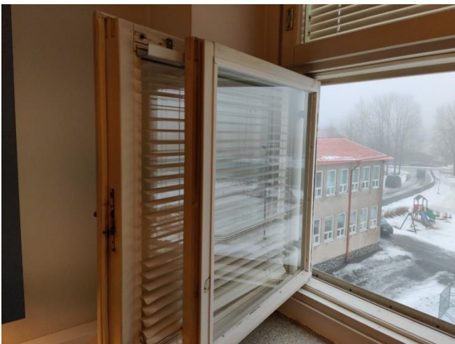
Kuva 46. Luokkien 1980-luvulla uusittu ikkuna.
