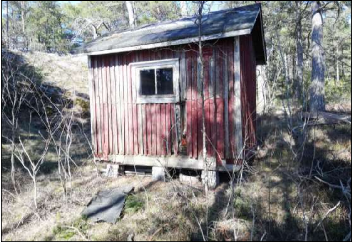
Kuva 14: Talousrakennus etelän suunnasta.
