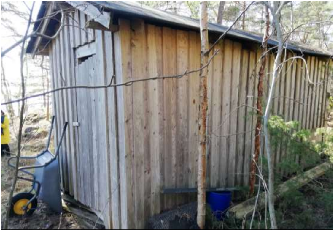
Kuva 12: Talousrakennus pohjoisen suunnasta.
