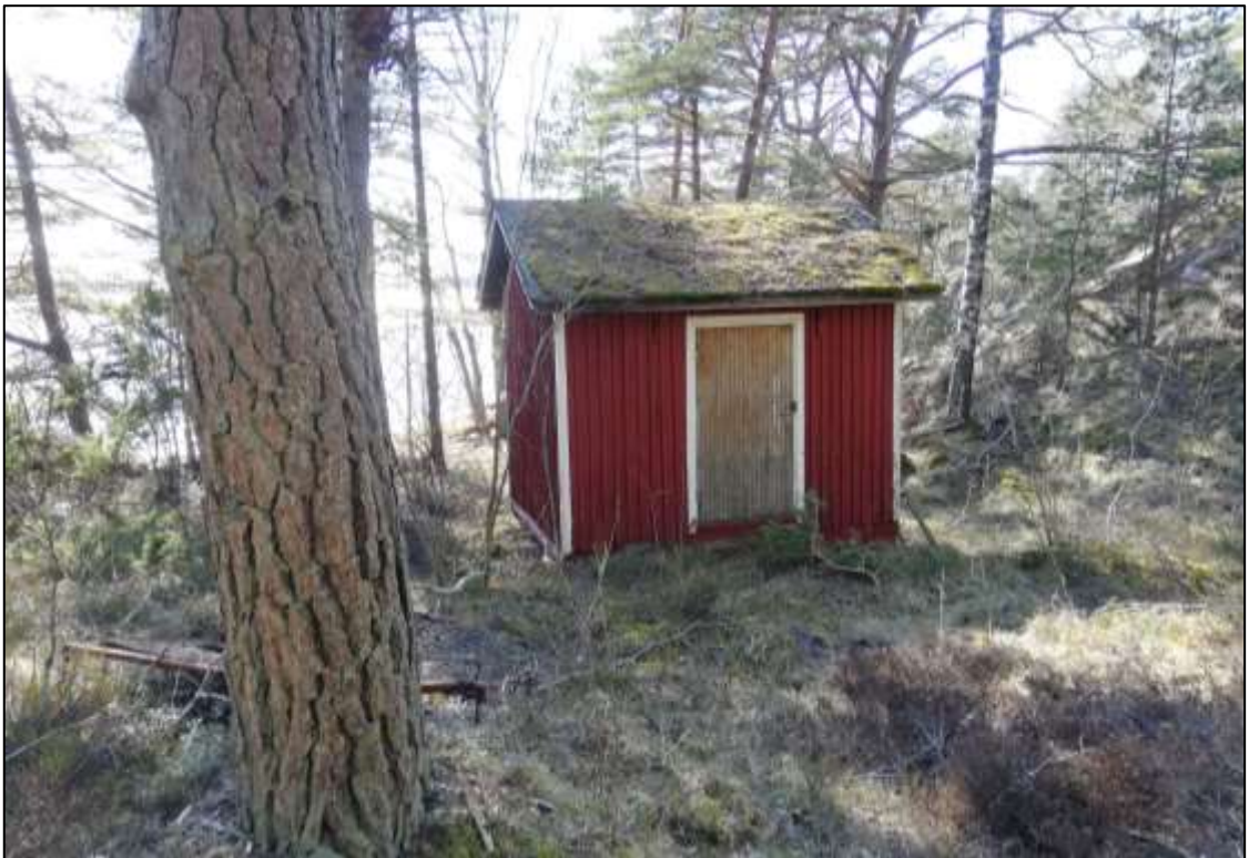
Kuva 13: Talousrakennus pohjoisen suunnasta.
