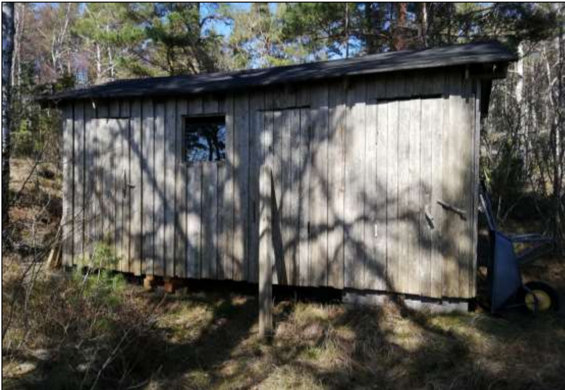
Kuva 11: Talousrakennus etelän suunnasta.
