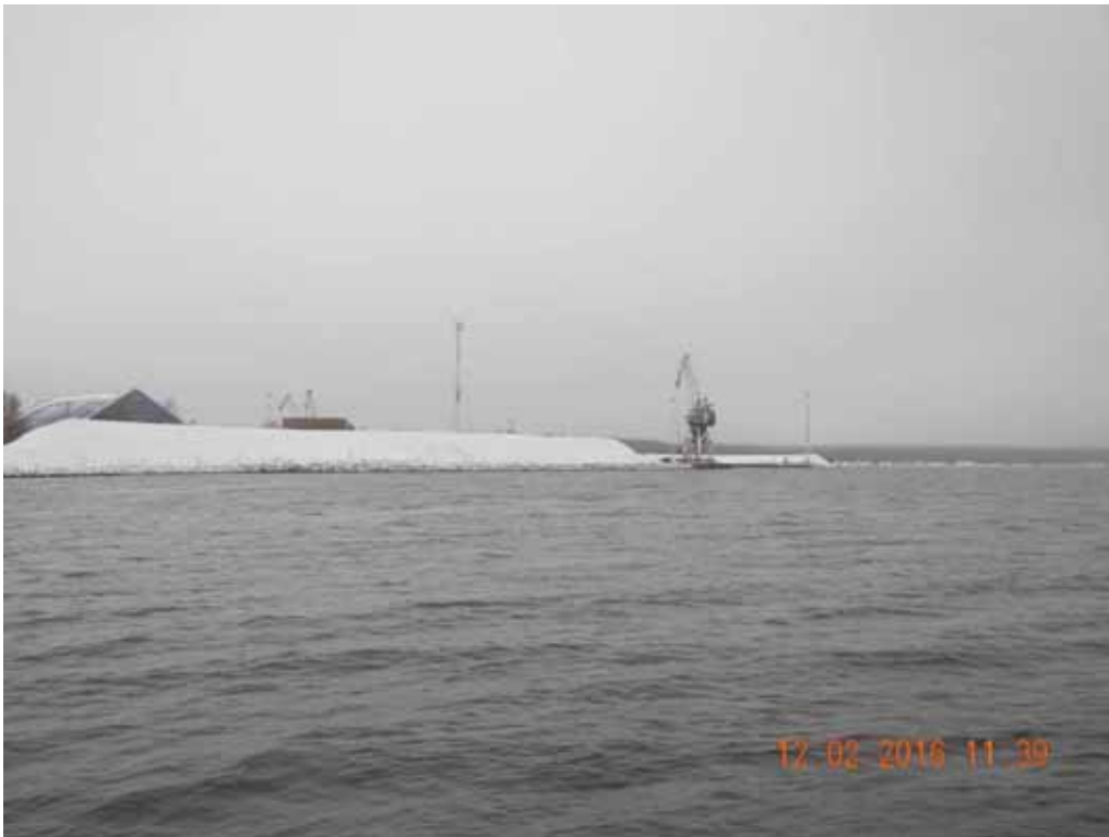
Kuva 28. Pengerrettyä rantavyöhykettä suunnitellun uuden laiturin kohdalla.
