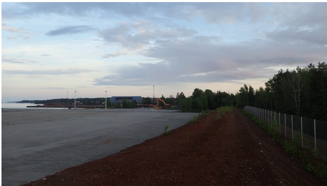
Kuva 2. Satama-alueita pohjoisesta kuvattuna
