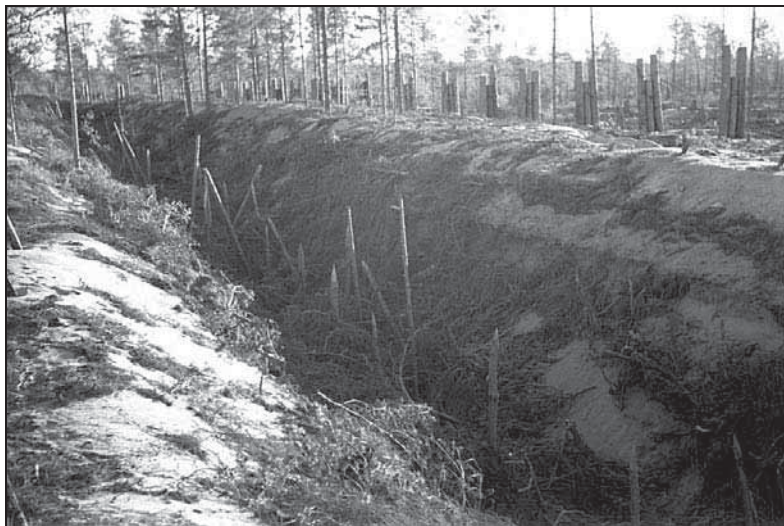
Kuva 10 Suoraviivainen kaivantoeste Hangon rintamalla. Esteen pohjalla on teroitettuja piikkejä ja sen taustalla puutolppia, joiden päällä on ollut teräskiskoja panssariesteenä. Kuva: Nro 115599. SA-kuva.
