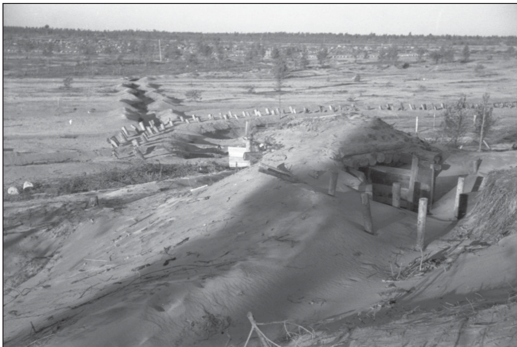
Kuva 3 Konekivääriasema nähtynä takaapäin. Aseman edessä on kaivantoeeste, jonka edessä on lisäksi panssarivaunuja varten tehty vinopaaluuste. Tukikohtaan johtaa etumaastosta mutkitteleva yhdyshauta. Kuvan yläosassa erottuu heikosti myös kiviesterivi. Kuva: A. Öhrnberg, lokakuu 1942. Nro 114595. SA-kuva.
